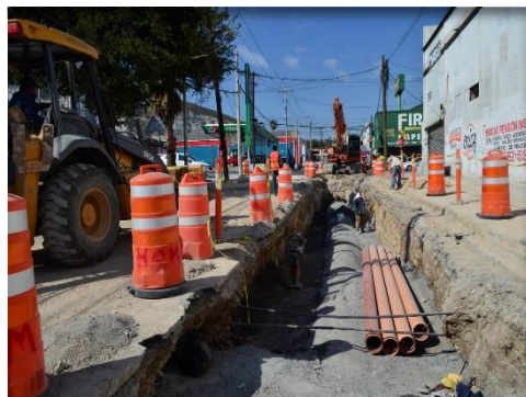
Construcción de Drenaje Pluvial en la calle Terán de la Colonia Toño Chico. Monterrey N.L.
