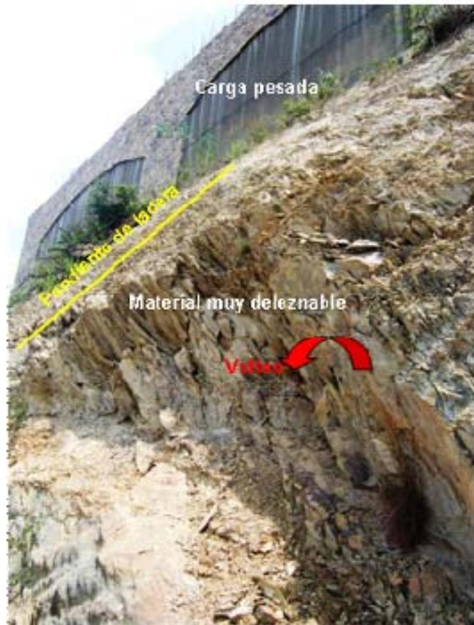
Fotografía 14. Áreas en alto riesgo dada la presencia de material muy intemperizable
