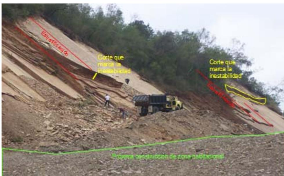
Fotografía 5. Inestabilidad de una ladera: tanto la inclinación de la ladera como la de la discontinuidad son paralelas; los cortes que se han efectuado aceleran el deslizamiento por falla planar de los estratos.
