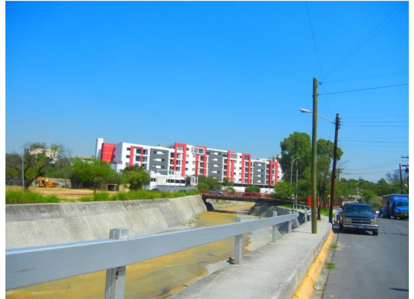
Canalización del Arroyo Seco con muros de concreto y reducción del mismo.
