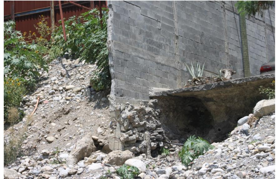
Barda proyectada hacia dentro del cauce del río, la sección que estaba dentro fue derribada por la fuerza del agua, localizada en Contry.
