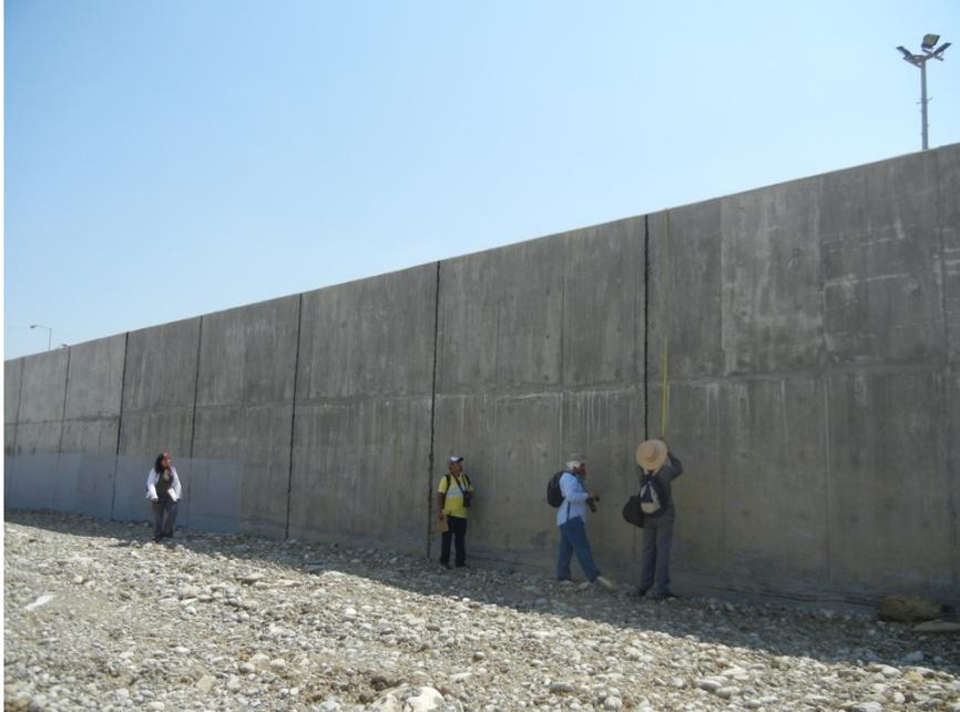
Barda de concreto para contención del agua al incrementar su nivel, establecido en Rincón de La Primavera con altura de 5 m.
