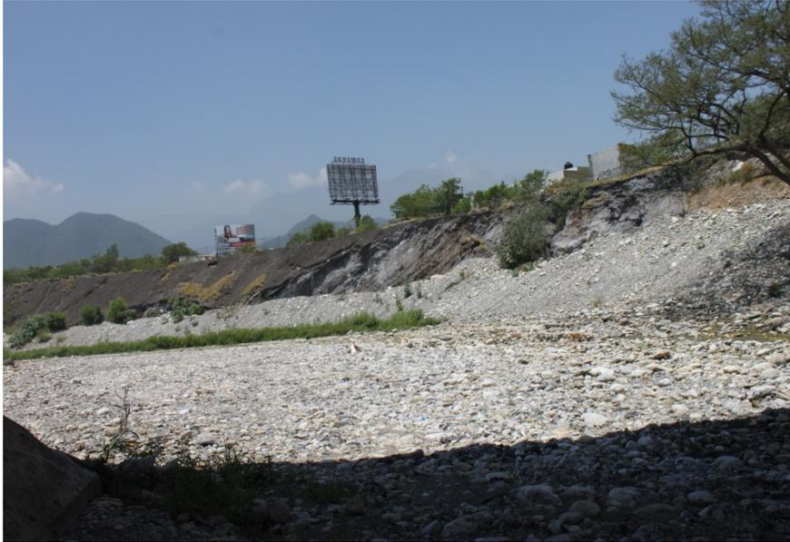
Cauce del río sin vegetación, al fondo se puede apreciar reforzamiento del bordo con material asfaltado el cual no ha sido suficiente para contener la fuerza del agua del río la Silla localizado en el sector Contry.
