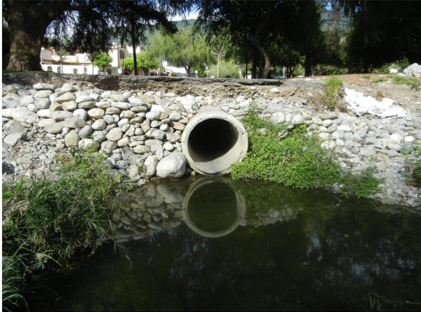
Drenaje pluvial con diámetro de un metro, localizado en el sitio de Contry.
