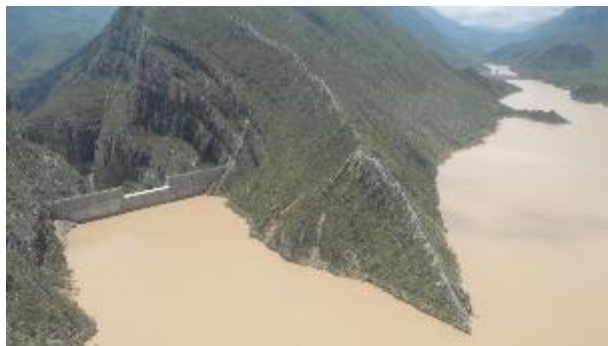
Figura 32. Rompe Picos, Huracán Alex 2010 Fuente: U-ERRE
