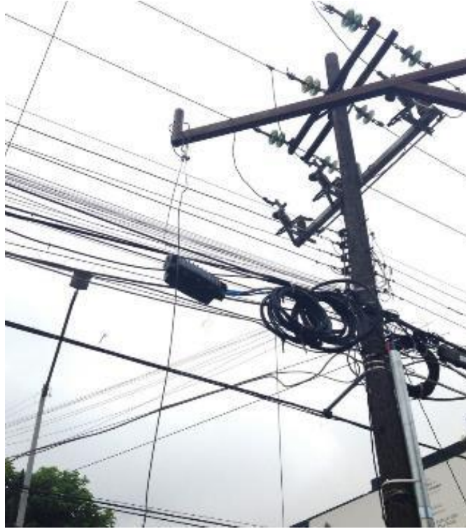
Figuras 17. Estado típico del tendido aéreo del cableado eléctrico y de comunicaciones
